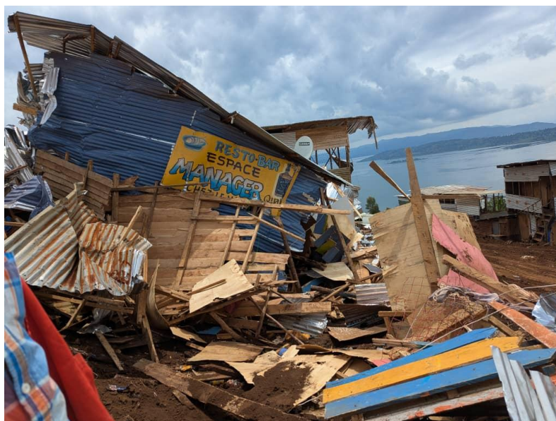
Structures appartenant à des civil-e-s détruites par le M23 en avril 2026 sur le site minier de Lomera (province du Sud-Kivu), dans l'est de la RDC. © DR
